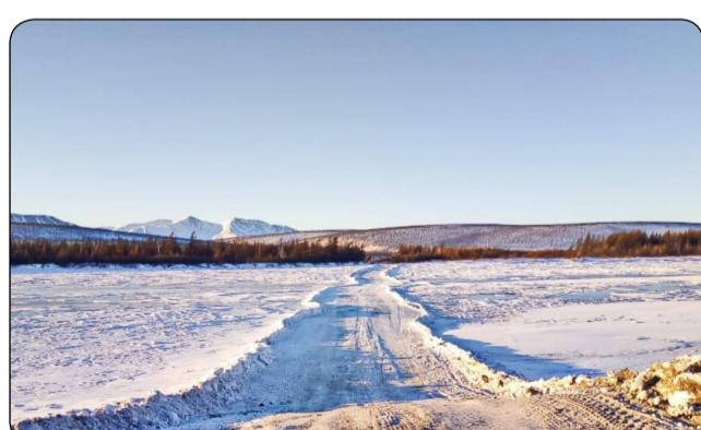
Протяженность зимника составляет 140 километров, а несущая способность – 10 тонн для автомобилей в потоке и 40 тонн – при одиночном передвижении.
